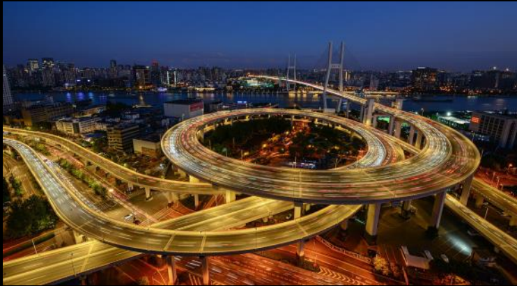
Nanpu Bridge 6 Zhicai Ren China
